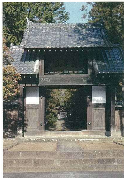
大泉寺総門 廃寺となった永慶寺の建物は、破却するにはしのびなく、近隣の寺院に寄進されたといえます。武田信虎の菩提寺大泉寺には本堂と総門が移築されました。本堂はその後火災に遭い、総門のみが現存します。
