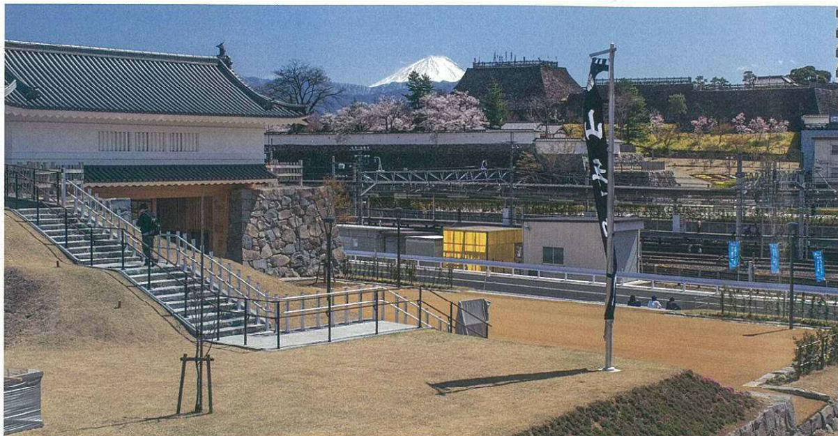
甲府城山手渡櫓門
