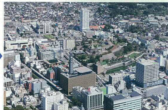
▲現在の甲府市庁舎上空より
