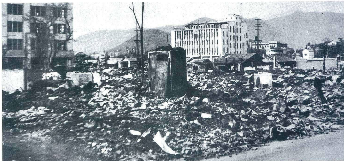
コンクリート製のビルを残して一面の焦土となった甲府市中心街。左は松林軒、右は岡島百貨店
